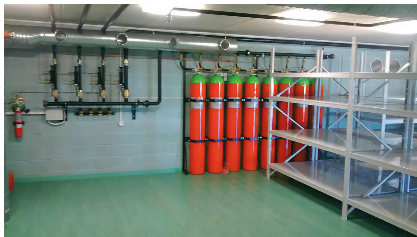
Raadi hoidlate gaaskustutusüsteem. Foto: Erkki Pärt
