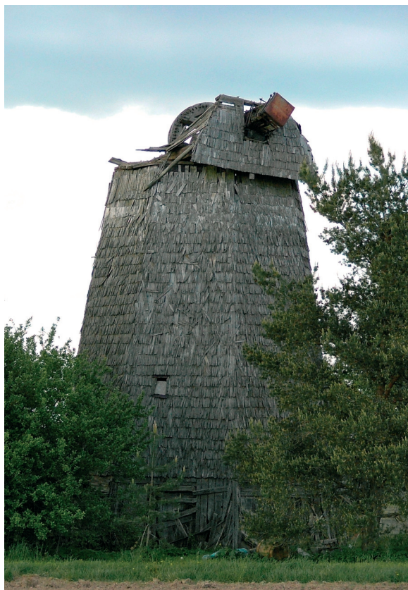
Foto 3. Puhja Koni tuuleveski. Tartu maakond, Puhja (kultuurimälestis nr 7250). Tuuleveski on ehitatud 1893. Foto Jaan Vali 2004.
