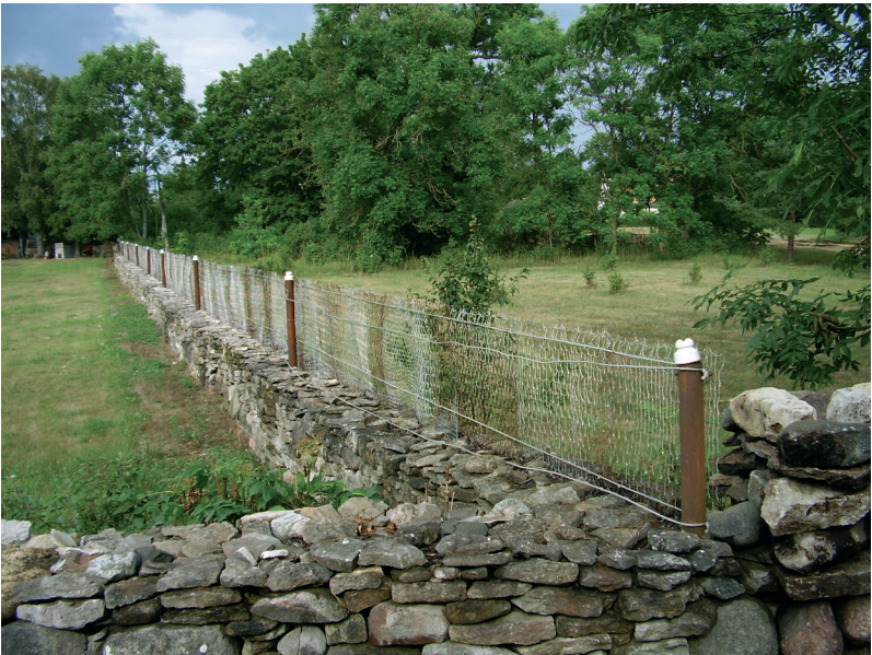
Foto 8. Traatvõrguga kõrgendatud kiviaed. Võrgupostide otsas vihmavarjuks pandud elektrisolaatorid. Kailuka küla, Pihla vald, Saaremaa. Foto Liisa Põld 2006.
