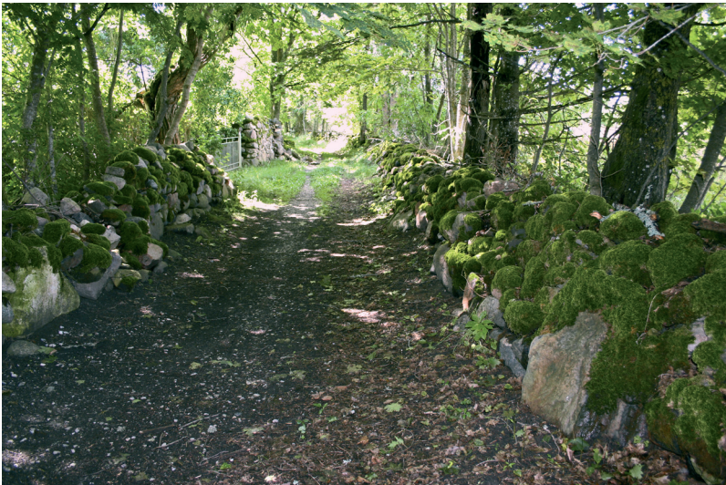
Foto 2. Kiviaedadega ääristatud, hästi säilinud vana karjatänav Siiksaare külas Jaagu ja Tooma talu ümber. Aedade kõrgus on umbes 1,2–1,3 meetrit, aluse laius 1–1,2 meetrit, harja kuju kuhikulaadne, laius enamasti 60–70 cm. Karjatänav enda laius on 2,5–3 meetrit. Valjala vald, Saaremaa. Foto Madis Rennu 2005.
